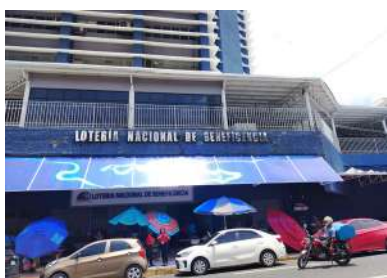
Suministro e instalación de láminas de policarbonato en parte frontal del edificio principal de la LNB en Ave. Cuba
