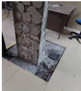
Agencia de Río Abajo - Rehabilitación de columna, apuntalamiento de losa, reemplazo de canal y cielo raso suspendido (antes y después).
