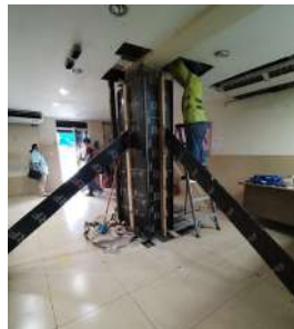
Agencia de Río Abajo - Rehabilitación de columna, apuntalamiento de losa, reemplazo de canal y cielo raso suspendido (antes y después).
