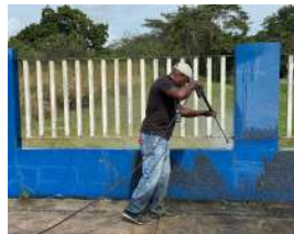
Mantenimiento de pintura
