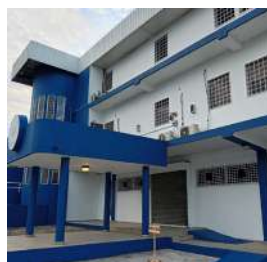
Mantenimiento de pintura
